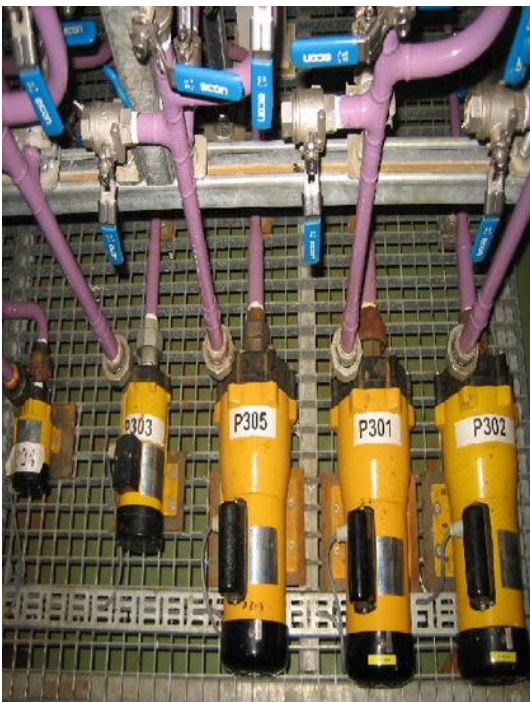
Afbeelding 3 Pompenstraat met centrifugaalpomp van de 300 unit
