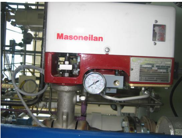
Afbeelding 7 drukregelklep 3PCV-001
