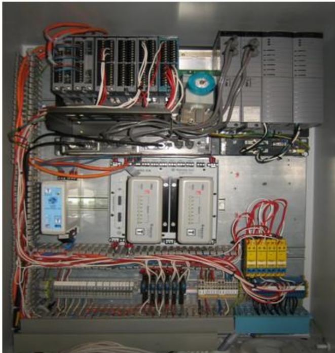
Afbeelding 2: DCS systeem 200 unit; hardware componenten in instrumentatie kast
